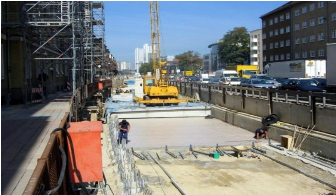
Aanbouw van de Richard Strauss tunnel in München met toepassing van dwarsfasering. Direct langs de bouwplaats wordt het verkeer met 2x2 rijstroken afgewikkeld.
